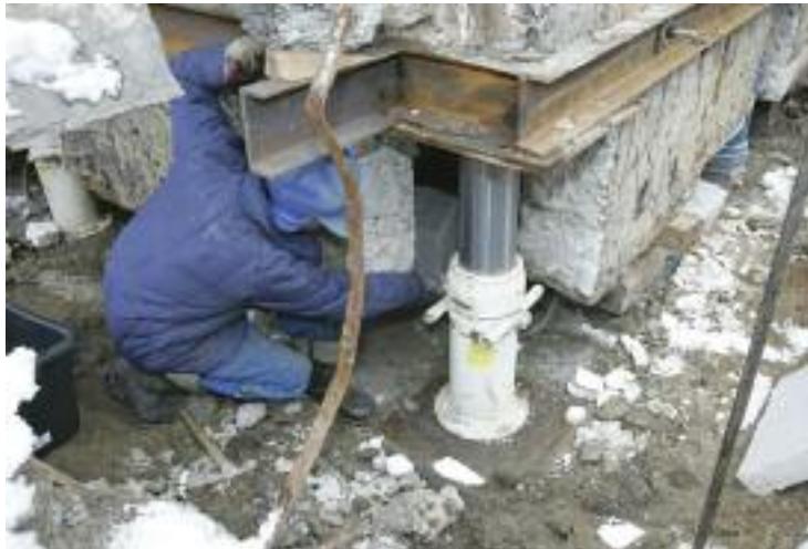
Rektyfikacja budynku wielorodzinnego w Katowicach przy ul. W. Pola 77/85.
