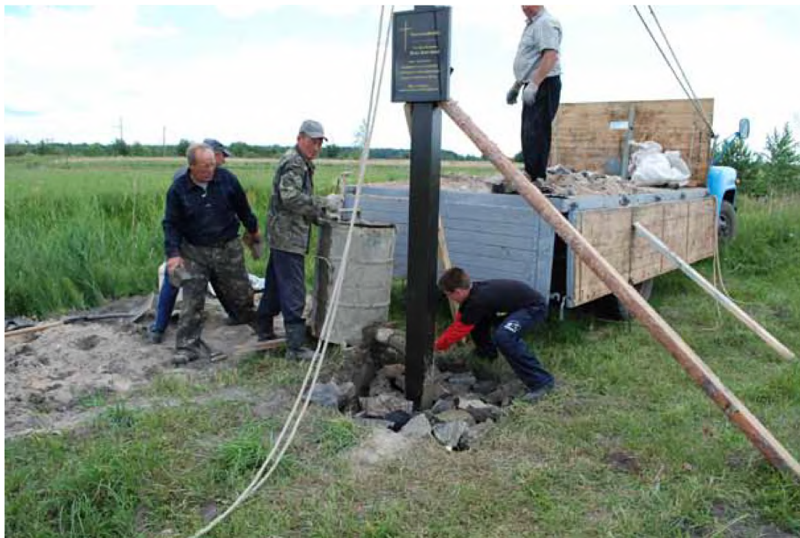
/ Betonujemy krzyż w Kamionce Nowej
