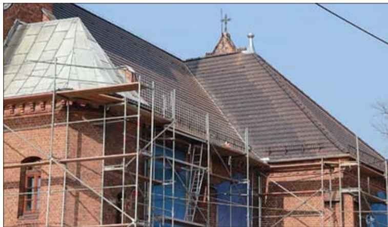
Z placu kościelnego niebawem znikną rusztowania.
