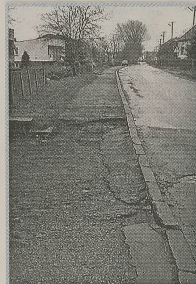
WJAZD PRZY UL. KASZTANOWEJ 3
