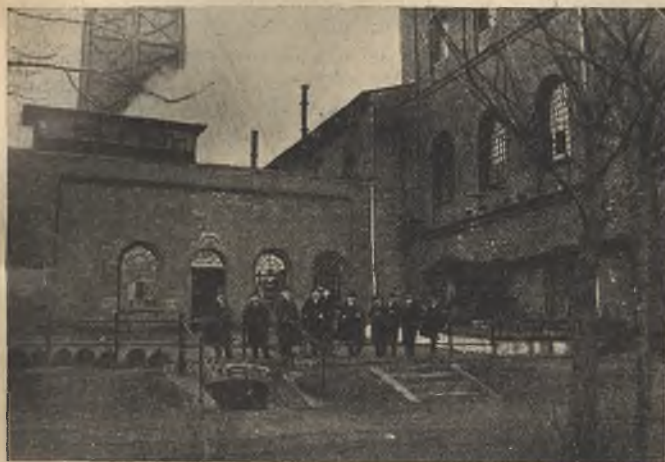
Powiatowy Zakład Wodociągowy. Stacja pomp nad rzeką Brynicą.
