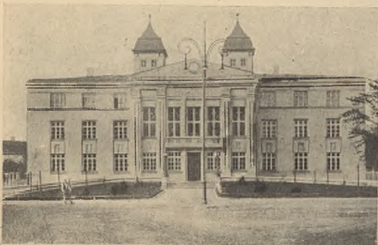
Gmina Chorzów, Nowy Ratusz, wybudowany 1924-5.
