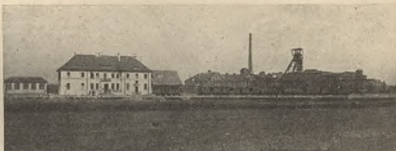
Dworzec Brzeziny Śl. z kopalnią węgla „Andaluzja“.
