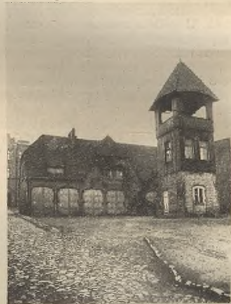
Remiza Straży Pożarnej
