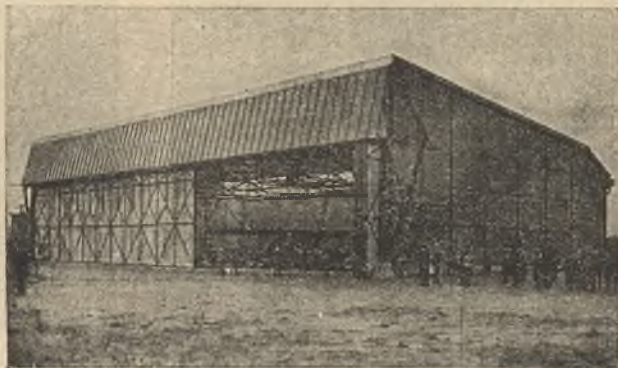
Hangar lotniska Katowickiego.
