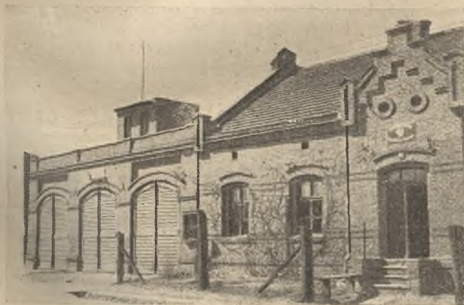
Remiza Straży Pożarnej.
