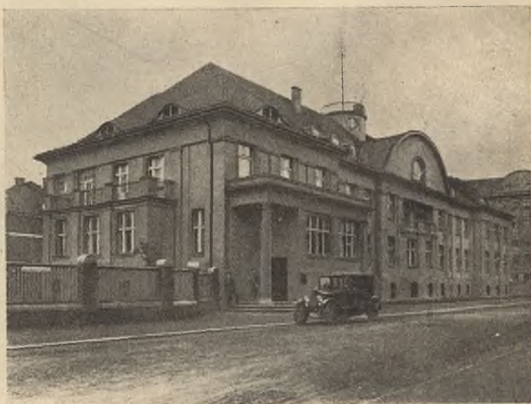
Ogólny widok gmachu Generalnej Dyrekcji.
