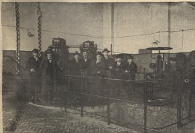
Powiatowy Zakład Wodociągowy w kopalni „Rozalji“, którego rozbudowa jest zasługą obecnego Wydziału Powiatowego w Katowicach.
