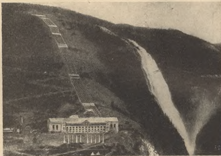
Stacja hydroelektryczna „Rjukanfos“ w Norwegii. Rurociągi dostarczyła i zmontowała Sp. Akc. „Ferrum“, Katowice.
