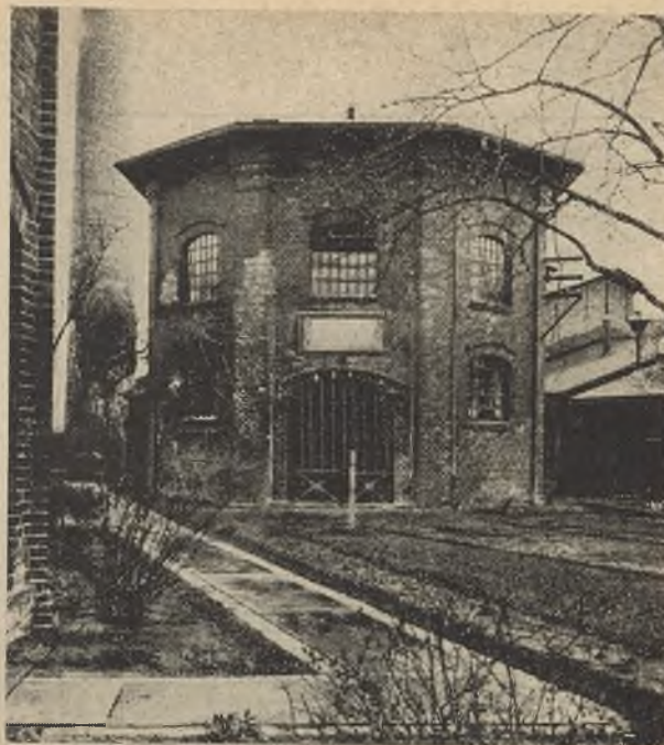
Wejście do Szybu „Staszica“ w Stacji Pomp.
