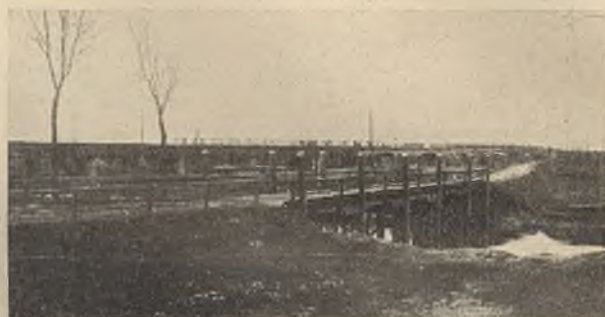
Nowobudujący się most na Wiśle pod Goczałkowicami.
