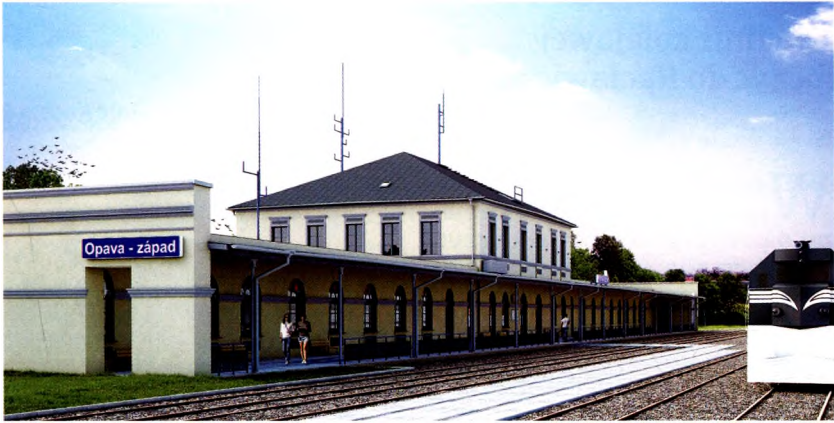
Projekt renowacji stacji kolejowej Opava - Zápád. Fot. idnes.cz
