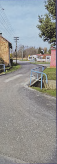
Nowa nawierzchnia asfaltowa w Zawiszycach
