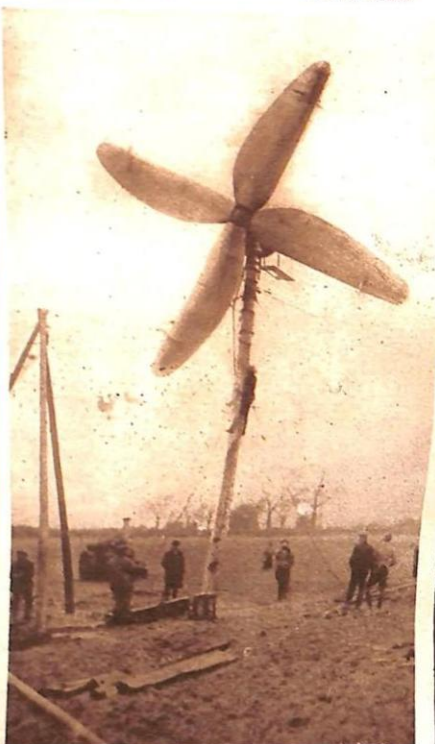
Elektryczność z powietrza. W angielskim hrabstwie Bedford w miejscowości Luton wystawiono na próbę nowego systemu wiatrak, służący do otrzymywania siły elektrycznej z powietrza.
