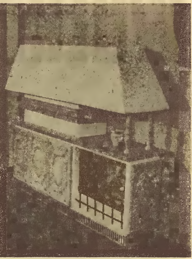
Stylizowany kominek kryje w sobie wnętrzu nowoczesny piec akumulacyjny.
