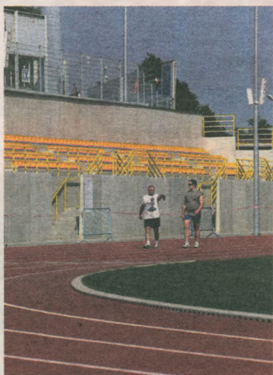
Stadion już gotowy, została przysłowiowa kosmetyka
