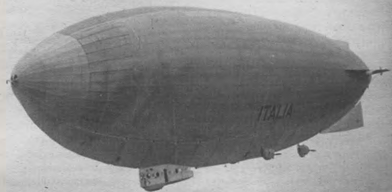
Sterowiec Italia zbudowany w 1924 roku, długość 105,4 m, średnica powłoki 19,4 m
