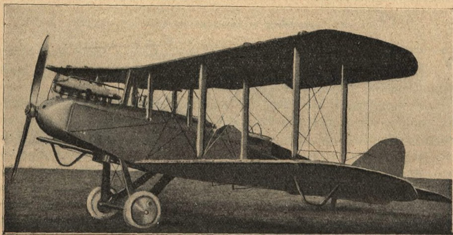
(Ryc. 119). Dwupłatowiec wywiadowczy De Havilland typu D. H. 9 o 240 MK. silniku B. H. P. Siddeley-Puma.
