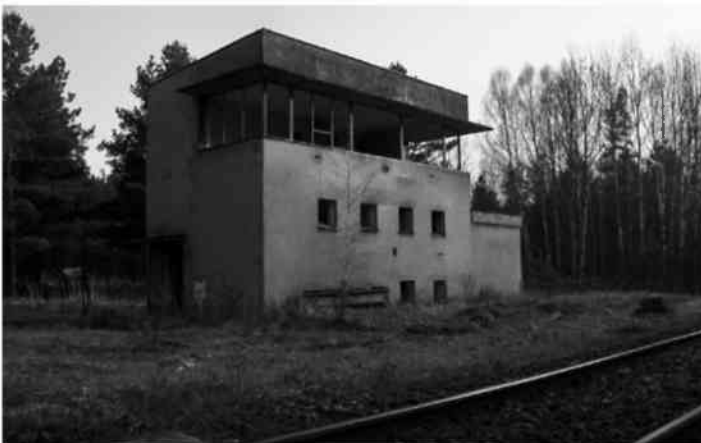
Nastawnia przy dawnym dworcu w Kokotku. Stan z 2007 roku. Obecnie budynek nie istnieje, został rozebrany podczas remontu linii kolejowej Nr 152 Pyskowice – Lubliniec w 2012 roku. Fot. Zbigniew Chromik, dnia 16 marca 2007 roku
