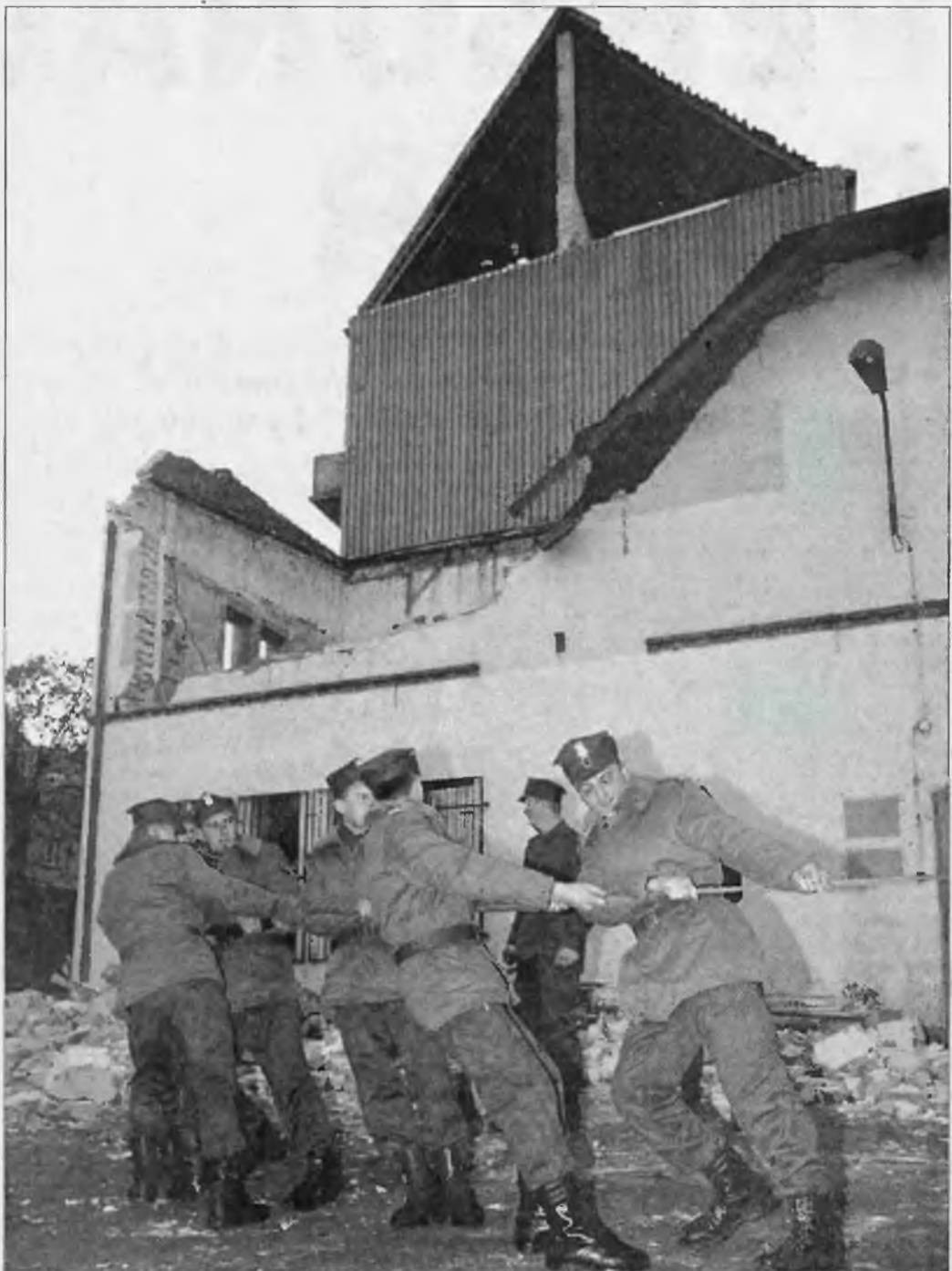
Wichura, która wczoraj po południu przeszła nad woj. toruńskim, zburzyła ścianę kamienicy w Chelmie... Uszkodzeniu uległ także przylegający do kamienicy niższy budynek.
