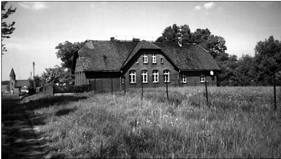
Budynek po nieczynnej szkole w Rzędowicach
