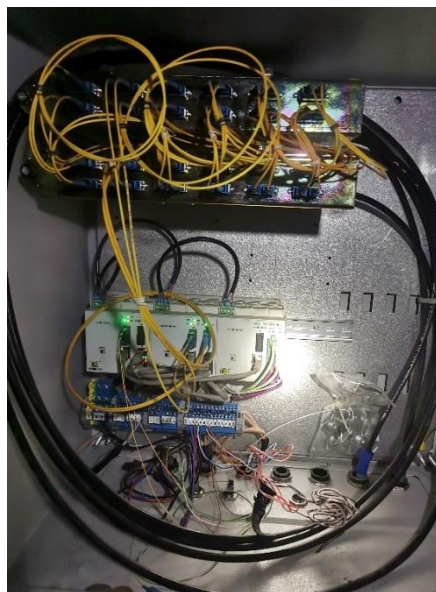
Rys. 6.36. Przełącznica światłowodowa EMFOS-18 firmy ELEKTROMETAL: widok ogólny przełącznicy oraz fotografia wnętrza przełącznicy w jednej z kopalń
