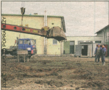
Budowa potrwa trzy lata
