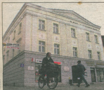
Sprawę kamienicy prześwietli komisja rewizyjna
