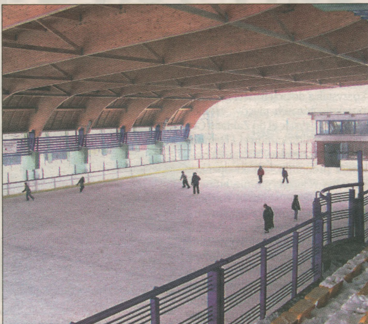
Wady na lodowisku ujawniono podczas odbioru
