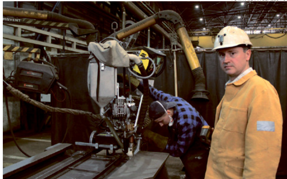
Bartłomiej Hrabia nadzoruje proces spawania łukiem krytym koryta przenośnika zgrzeblowego w hali ZRP PGG w Bieruniu.
