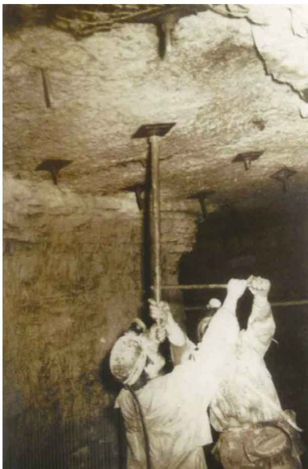
Kotwienie stropu na dole kopalni „Dąbrówka”
