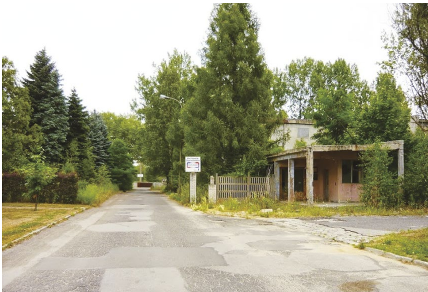
Droga dojazdowa do kopalni „Dąbrówka”. Widoczny na zdjęciu płot był częścią bramy wjazdowej na teren kopalni. Po prawej widoczne pozostałości po pomieszczeniach wartowni i markowni. Na dalszym planie (wyższy budynek) fragment cechowni.
