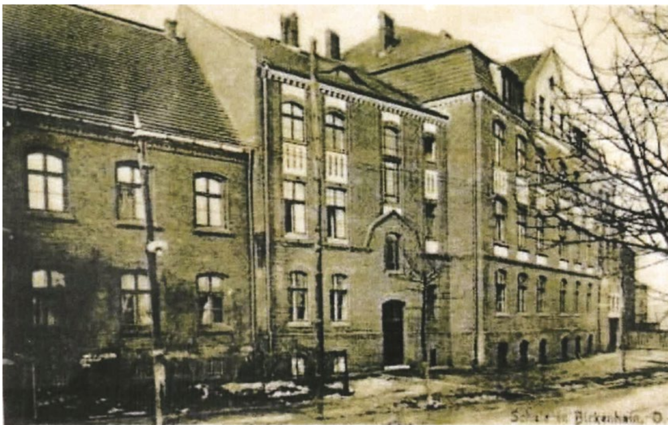
Szkoły Podstawowe w centrum gminy. Niższe dwa budynki to gmach Szkoły nr 3 wraz z mieszkaniami dla nauczycieli. Na dalszym planie (wyższy budynek) to Szkoła Podstawowa nr 1 z 1910 roku.
