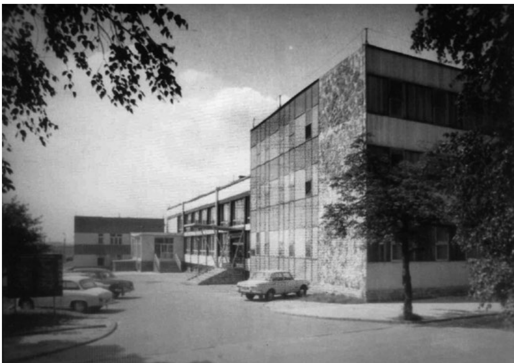
Budynek Domu Kultury KGH „Orzeł Biały”.
