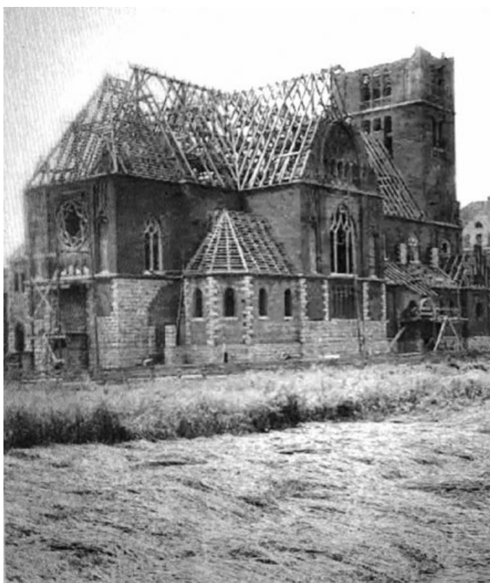
Rok 1914 / 1915. Budowa kościoła parafialnego w Brzezinach.
