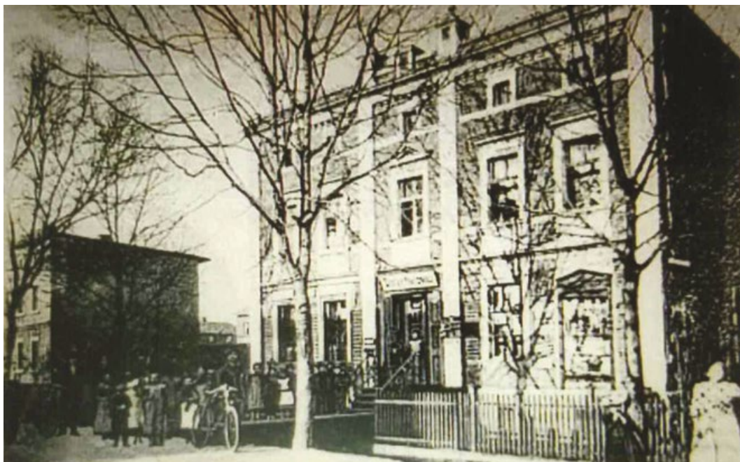
Dom Towarowy należący do St. Warzechy (budynek ze sklepem istnieje do czasów współczesnych przy ulicy ks. bpa Herberta Bednorza nr 48).
