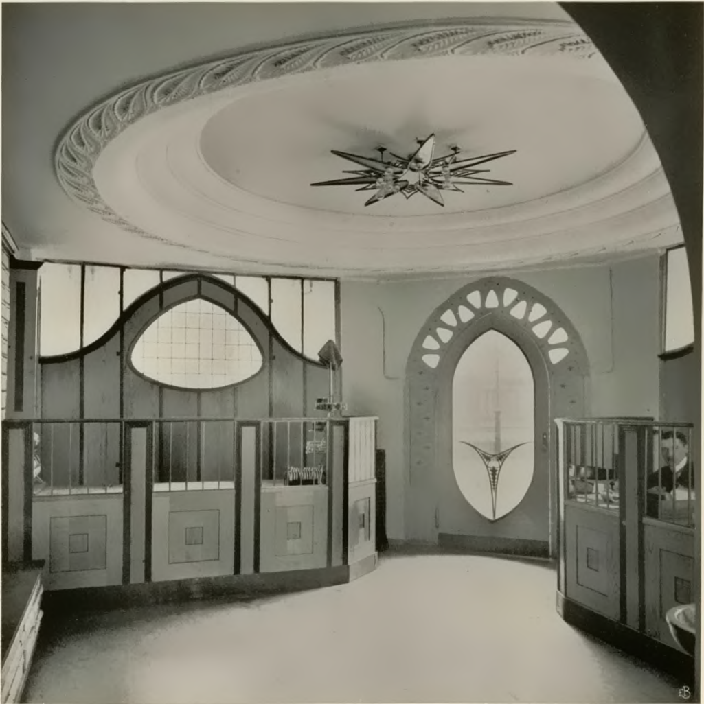
ARCH. AUGUST ENDELL-BERLIN ■ KASSERAUM DES „SALAMANDER“-LADENS IN DER TAUENZENSTRASSE
