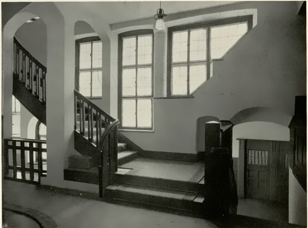
HAUS HENKELL ■ ■ OBEN: HAUSGANG IM OBERGESCHOSZ; UNTEN: AUFANG ZUM DACHGESCHOSZ
