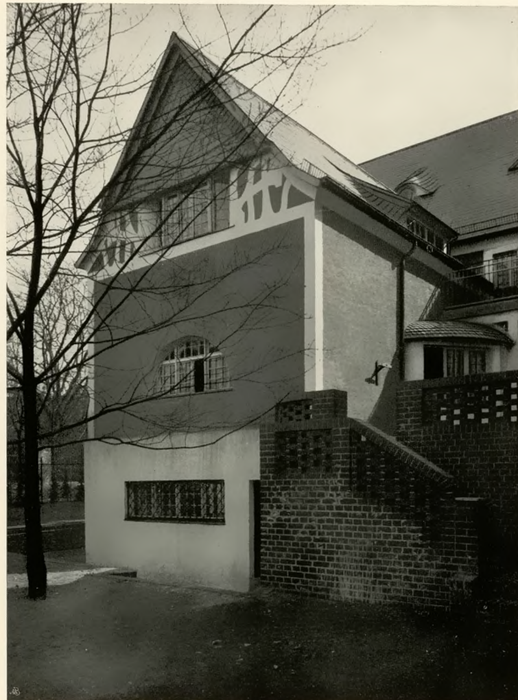
EINGANG UND WESTGIEBEL DES DIENSTGEBÄUDES
