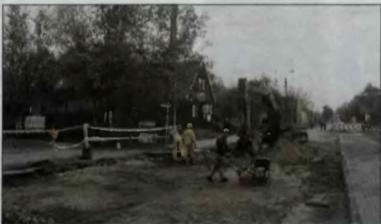
Firma wykonuje m.in. wszelkiego rodzaju roboty drogowe.
