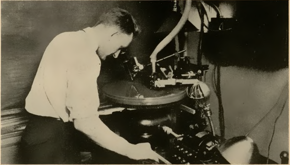
Der Aufnahme-Ingenieur prüft die Tonplatte während der Aufnahme
