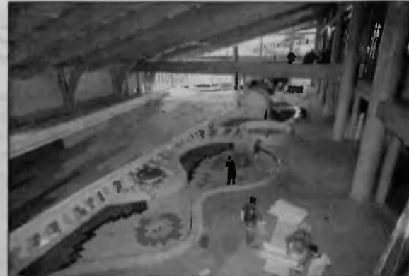
Budowa kompleksu trwała dwa lata.
