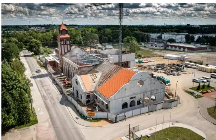
Fot. 15. Widok na rewitalizowaną Halę Zborną (cechownię) byłej kopalni „Saturn”
