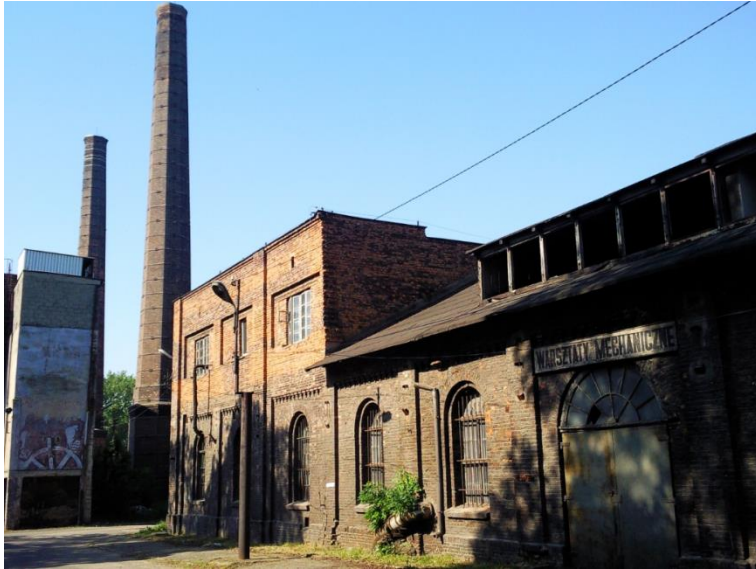
Fot. 16. Widok na dwa kominy kotłowni i budynek warsztatów mechanicznych byłej kopalni „Saturn”
