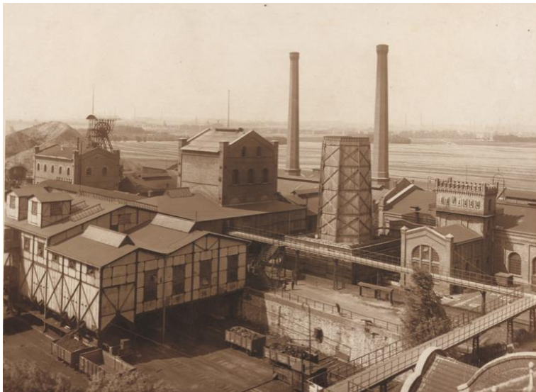
Fot. 17. Archiwalne zdjęcie wyglądu zabudowań byłej kopalni „Saturn”
