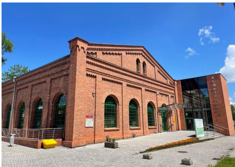
Fot. 1. Budynek Galerii Sztuki Współczesnej Elektrownia wraz z wejściem głównym
