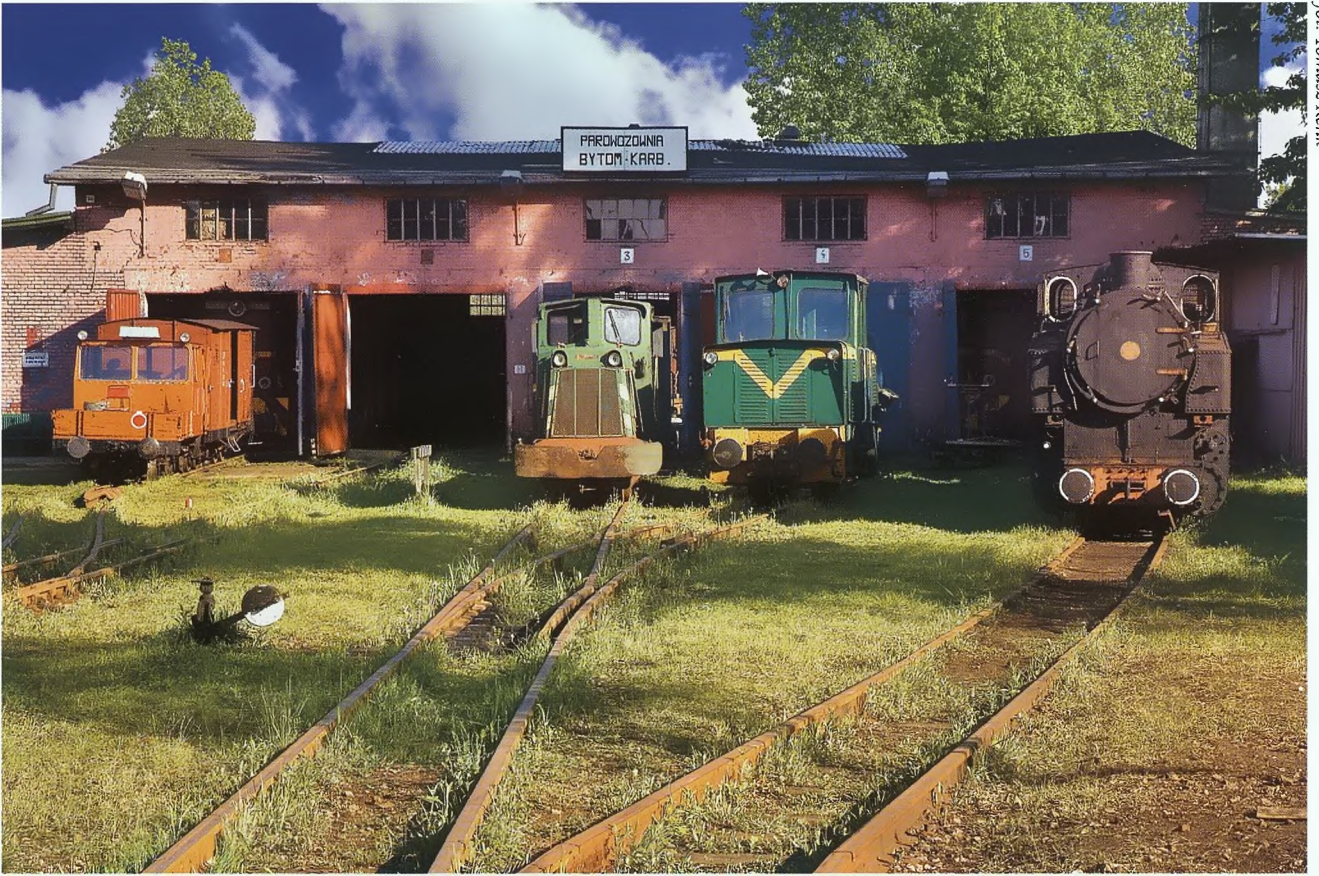
Parowozownia Bytom-Karb Wąskotorowa
