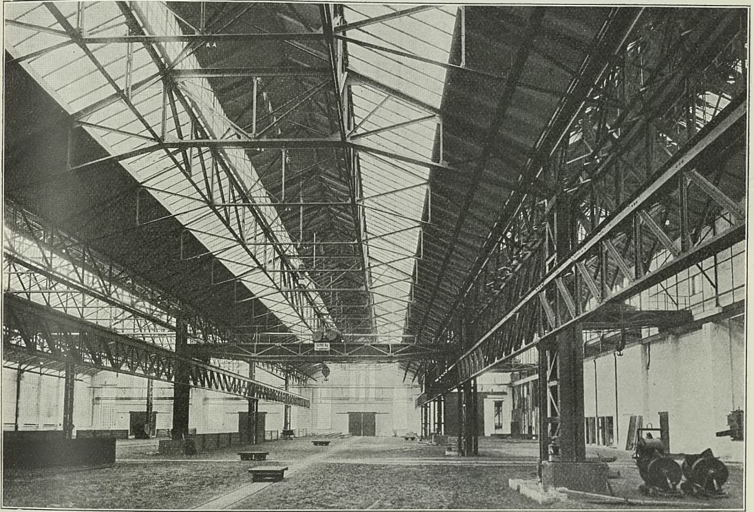
Abbildung 3. Gießereihalle vor der Inbetriebnahme.
