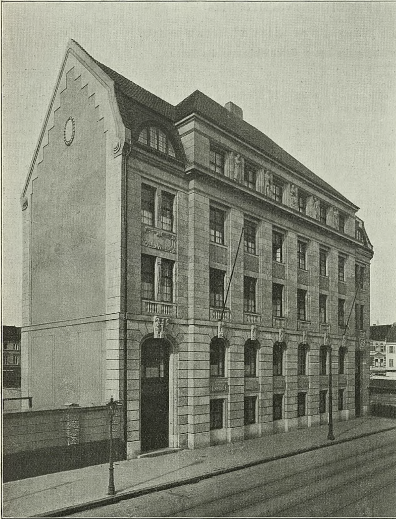
Das neue Geschäftshaus des Vereins deutscher Eisenhüttenleute in Düsseldorf, Breite Straße 27.
