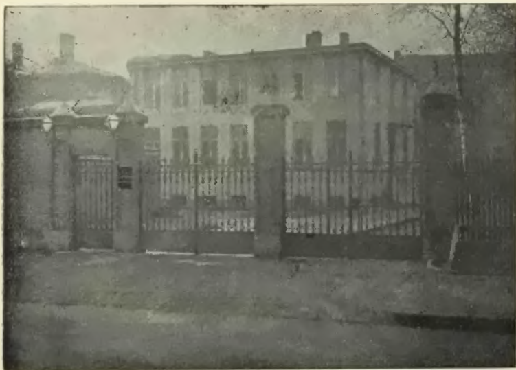
Gmach Centrali Telefonicznej w Sosnowcu.
