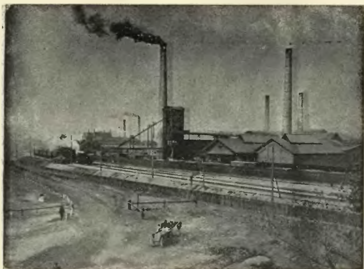
Sosnow. Zakł. fabryki rur i żelaza oraz plac Kościuszki przed 30 laty.
