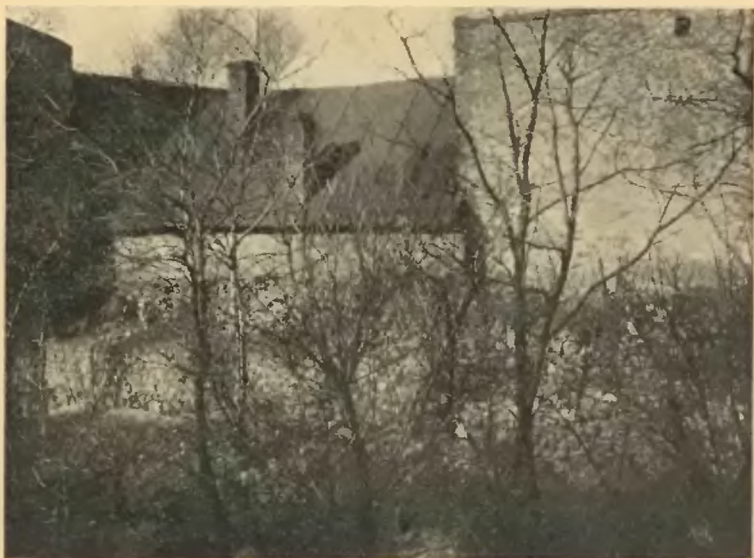
Będzin. Stary cmentarz żydowski przy ul. Zawale. W tyle resztki murów obronnych.
