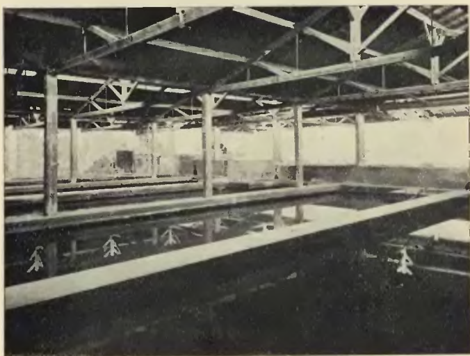
Filtry wodociągowe na kop. Paryż.
