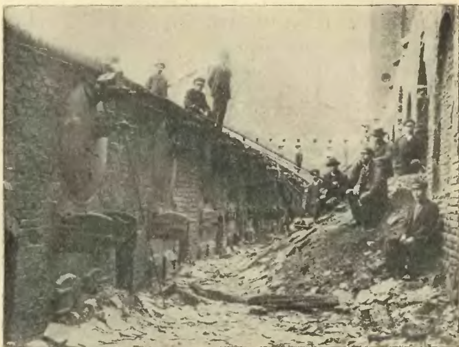
Widok spalonej kotłowni.
