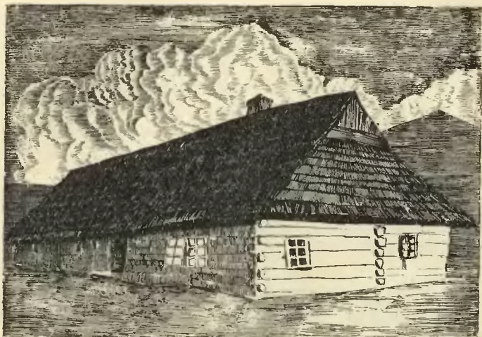
Stara Dąbrowa. Dom Bałdysa przy ul. Wiejskiej Nr. 6.
