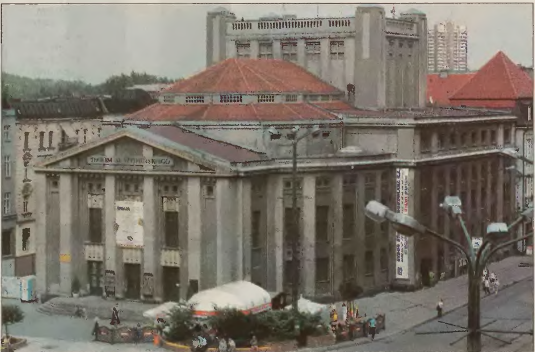
W tej chwili stan zaawansowania prac remontowych określa się na ok. 70 proc.
