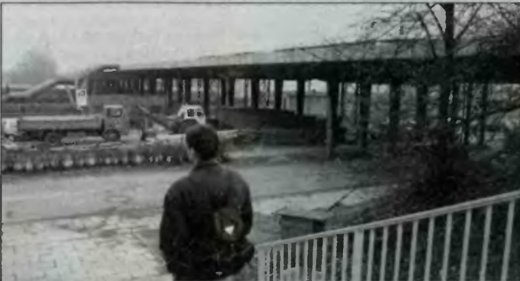
Czechowicki wiadukt może zostać zamknięty.
