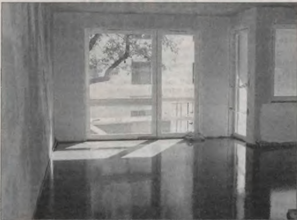
Dopiero na tak przygotowane podłoża kładziemy parkiet, płytki czy panele podłogowe.
