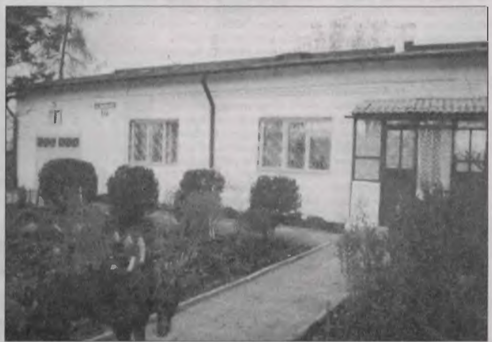
Ten dom nie wygląda na ruinę, a mimo to przeznaczono go do rozbiórki.
