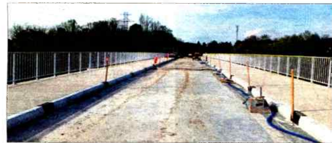
Postęp budowy robi wrażenie.
