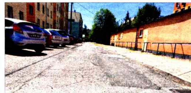
Droga zyska całkowicie nową nawierzchnię i odwodnienie.
