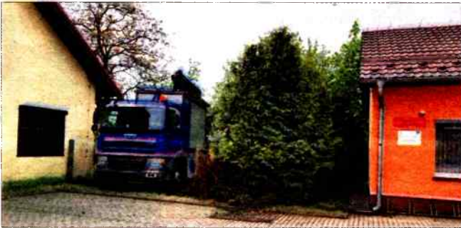
Wykonawca już rozpoczął prace.
