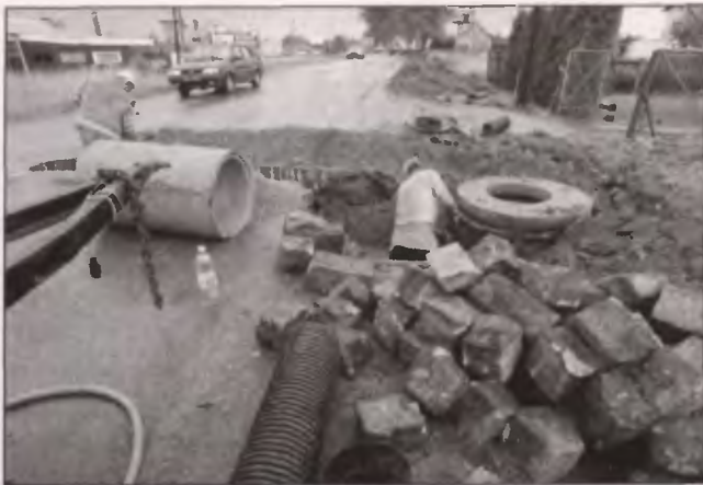
Prace przy budowie chodników w Babicach zakończą się jesienią.
