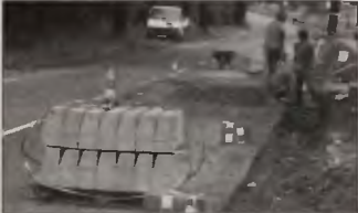
Pogoda sprzyja drogowcom, więc prace remontowe w Piekarach przebiegają w szybkim tempie.
