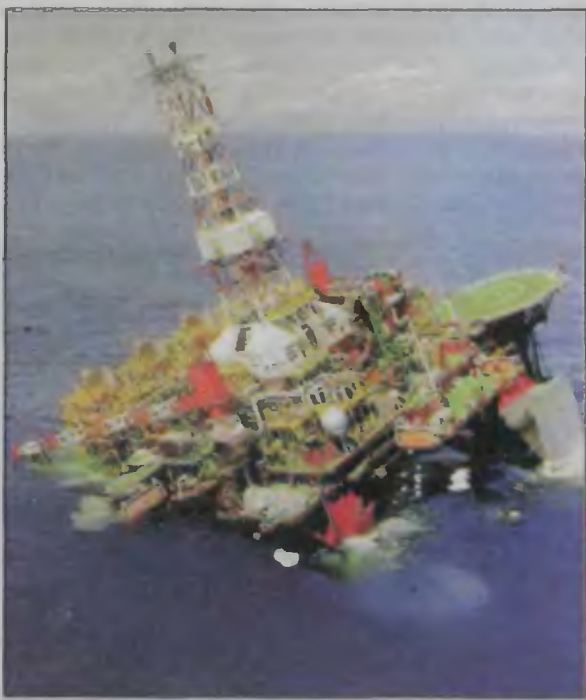
Wielka platforma naftowa Petrobras P-36, jedna z największych na świecie, w duzym przechyle po dwóch eksplozjach i pożarze 15 marca. Zginęła co najmniej jedna osoba. Według telewizji brazylijskiej, nie znany jest los co najmniej dziesięciu robotników pracujących na platformie. Platforma znajduje się na morzu w odległości ok. 220 km na północny wschód od Rio de Janeiro. ■
