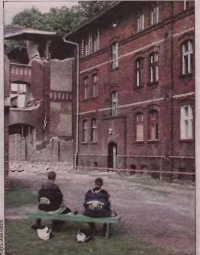
Po ewakuacji mieszkańców, strażacy zastanawiali się, jak zburzyć resztę ściany.
