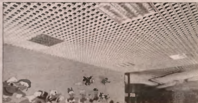
Ten rodzaj płyt sufitowych ma nie tylko ciekawą konstrukcję i wygląd, ale i ze względu na swoje właściwości akustyczne nadaje się do pomieszczeń konferencyjnych.
