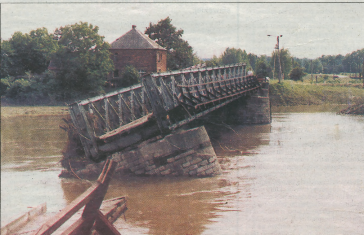
Zerwany most w Bukowie. Jeszcze dwa tygodnie temu prezentowaliśmy jego zdjęcie, gdy resztkami sił opierał się nurtowi Olzy.
