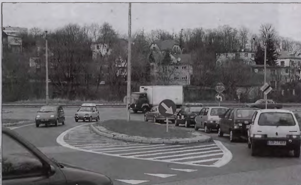
Problemy z przejazdem przez skrzyżowanie al. Armii Krajowej i Andersa znikną już w przyszłym roku – zapewnają drogowcy.
