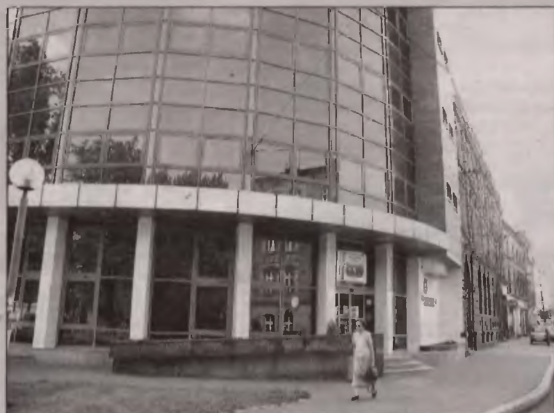
Rozdzielnia gazu przy ul. Katowickiej w Świątchłowicach.
