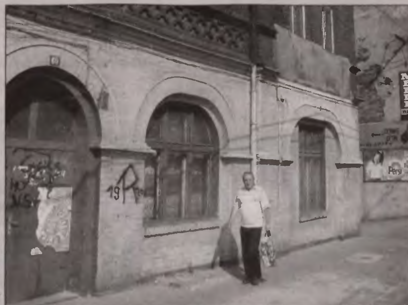
Stare kamienice przy tej samej ulicy.
