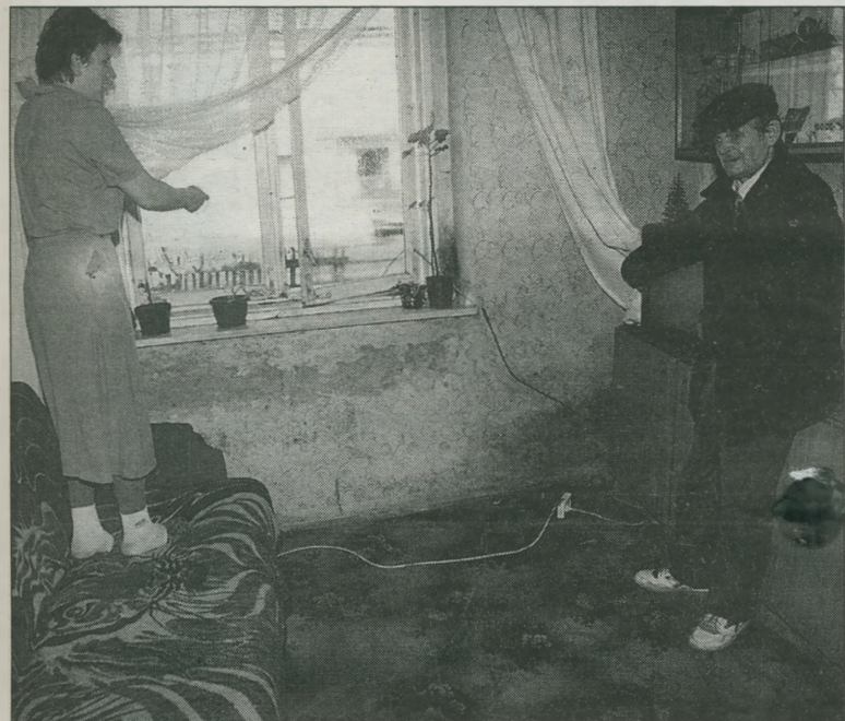
Lokatorzy „czworaków” mieszkają w zagrzybionych pokojach.
