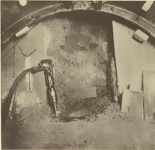
Chemische Bodenverfestigung für den Bau eines Sammelkanals in London (Brook Green Sewer)
