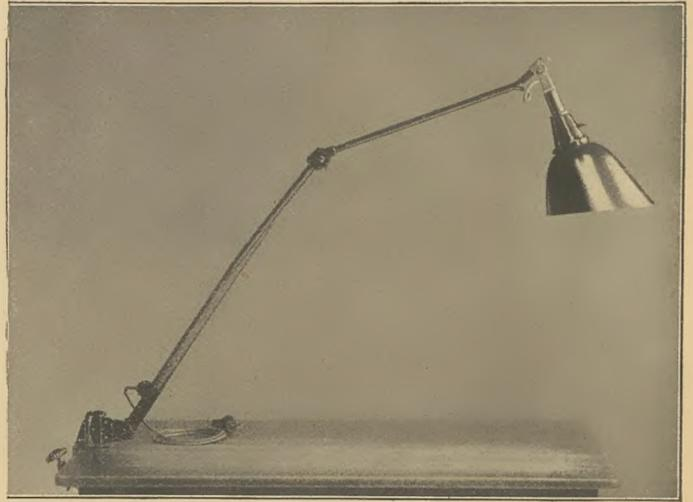
Leuchtgerät, dessen Reflektor beliebig verstellbar ist, so kann der Arbeiter den Lichteinfall stets so richten, daß Blendung vermieden wird. Diese Verstellbarkeit braucht er außerdem, um je nach Bedarf das Arbeitsstück von verschiedenen Seiten beleuchten zu können und um den Schattenfall so einzurichten, daß er bei der Arbeit nicht stört. Alles dies würde bei ausschließlicher Allgemeinbeleuchtung nicht möglich sein.
