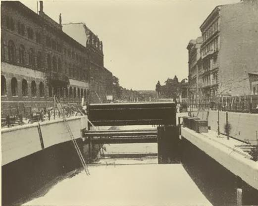
gleichem und für die Wasserführung ausreichenden Querschnitt mit  $50 \text{ m}^3$  (anstatt  $15 \text{ m}^3$ ) Wasserführung gebracht. An Stelle der alten Schleuse entstand ein Wehr von 13 m l. W. mit einer Bootschleuse von 3 m Breite für Sportboote. Eine Grundwasser-Absenkungsanlage mit SSW-Tiefbrunnenpumpen hielt die Baugrube trocken
