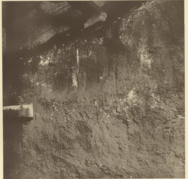
Chemisch verfestigter Boden unter den Hausfundamenten als Abfangung gegen eine tiefe Baugrube
