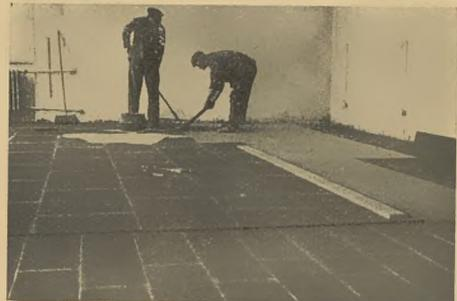
Doppelter Asonit-Fußboden in einem Fernsprechräum, ausgeführt für die Baubehörde Hamburg
