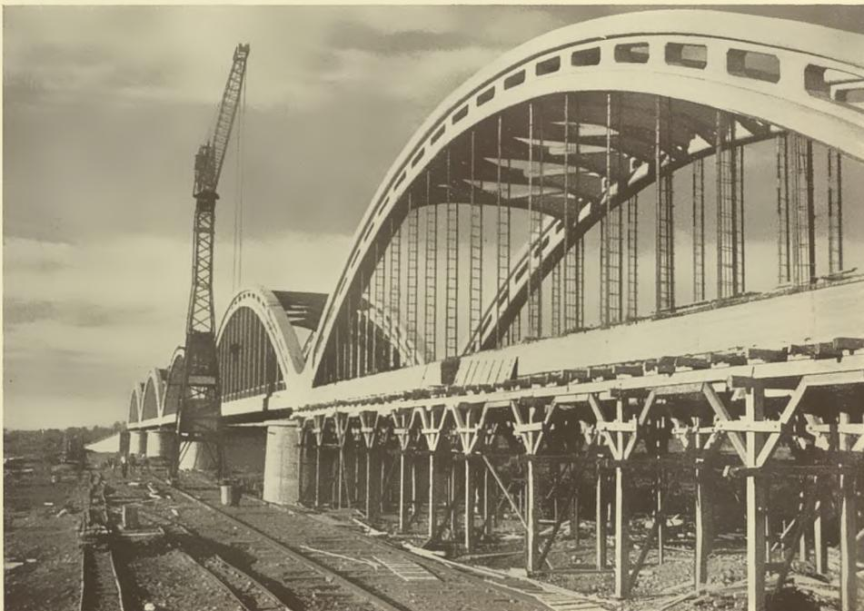
**Brücke über den Rio Diamante** Die Brücke führt über den Rio Diamante in Argentinien, Provinz Mendoza. Sie besteht aus vier Öffnungen von je 45 m, die durch Brückenbögen mit aufgehängter Fahrbahn überspannt werden. Die Brückenbögen wurden in Eisenbeton ausgeführt
