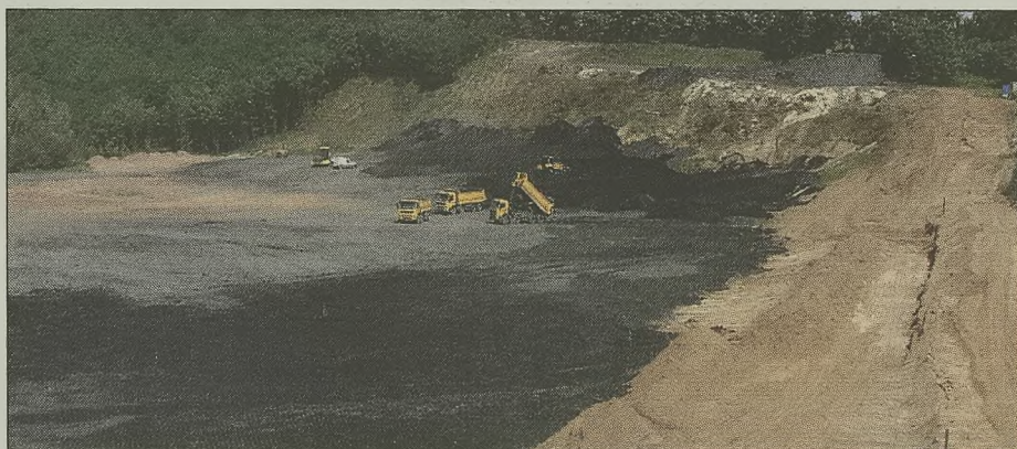
Obecnie powstaje niecka składowiska oraz kształtowane są skarpy kwatery, wykonywany jest drenaż wód gruntowych oraz tworzona sztuczna warstwa uszczelniająca z gliny.
