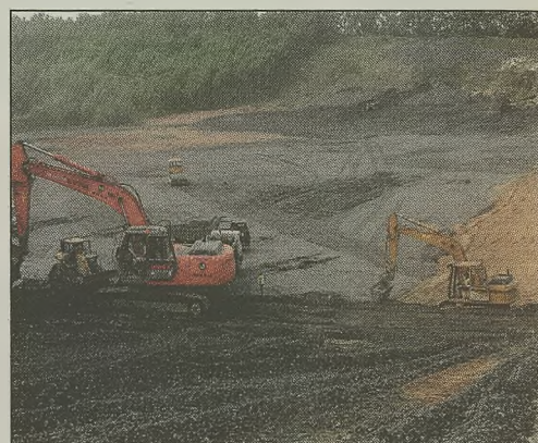
Obecnie powstaje niecka składowiska oraz kształtowane są skarpy kwatery, wykonywany jest drenaż wód gruntowych oraz tworzona sztuczna warstwa uszczelniająca z gliny.
