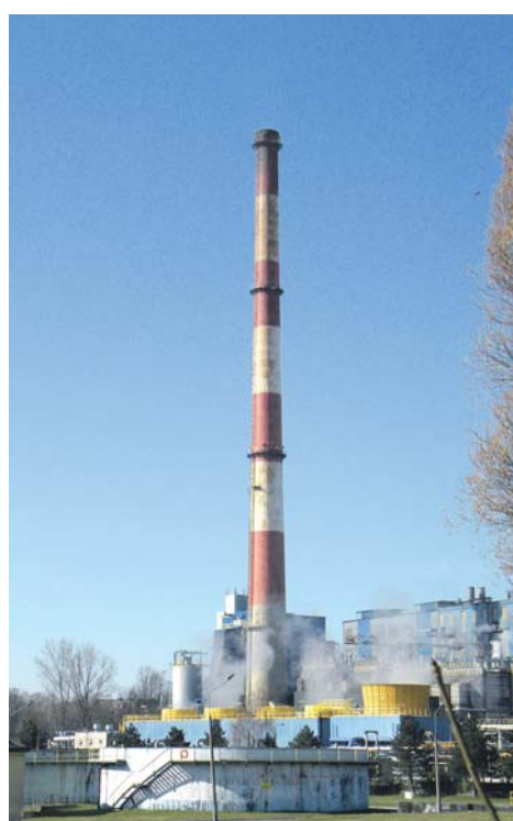
Widok na komin w trakcie normalnej, codziennej pracy dwóch kotłów parowych oraz turbozespołu. O pracy urządzeń świadczy unosząca się para wodna z czterech chłodni wentylatorowych.
