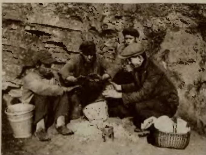
„Centralne ogrzewanie” w kopalni w czasie przerwy obiadowej.
