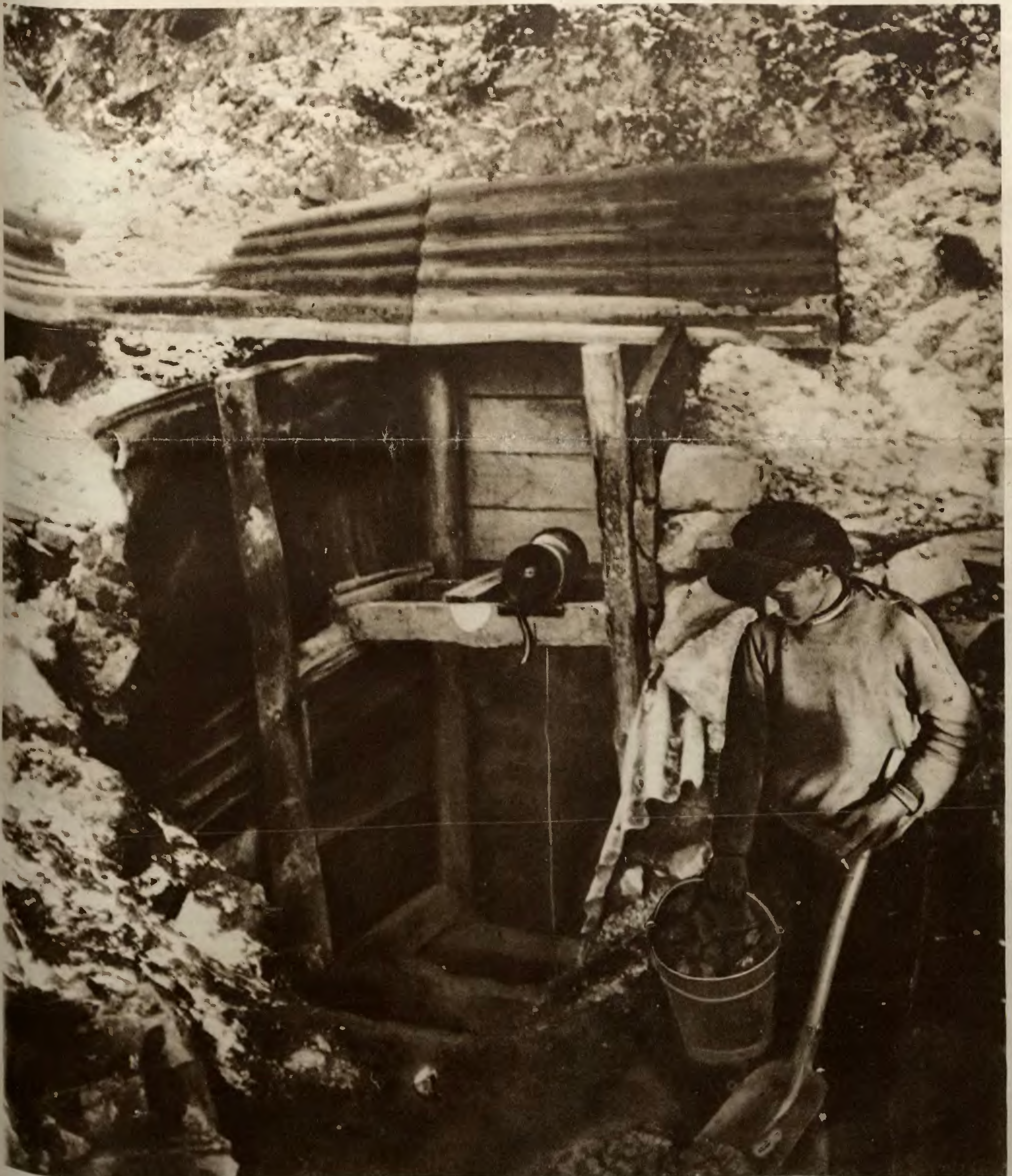
Szyb pionowy głębokości 18 metr. z windą kołową, oszalowany deskami, dający dziennie 2-3 tonny dobrego węgla przy pracy 5 robotników — w okolicy Katowic. (Patrz artykuł wewnątrz numeru).
