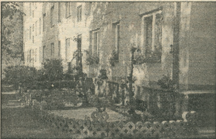
Tak wygląda rzekomo zdewastowane miejsce.
