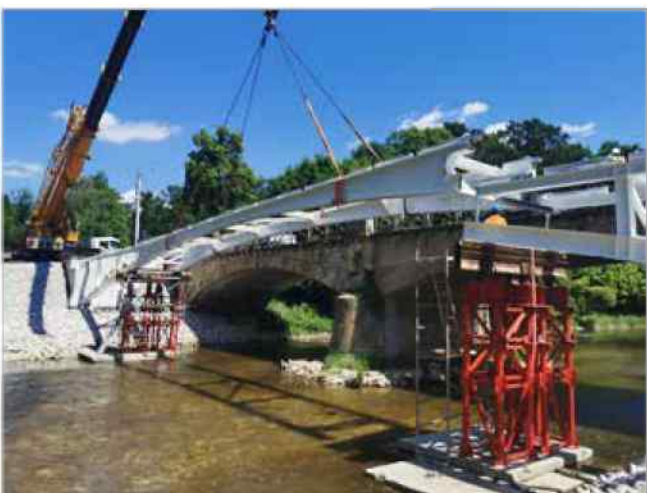
Budowa kładki pieszo-rowerowej w Turawie
