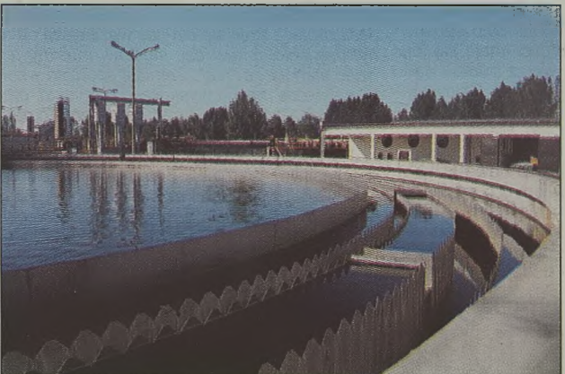
Dąbrowska oczyszczalnia „Budową Roku 1997”, do czego przysłużył się prezes Andrzej Malinowski.
