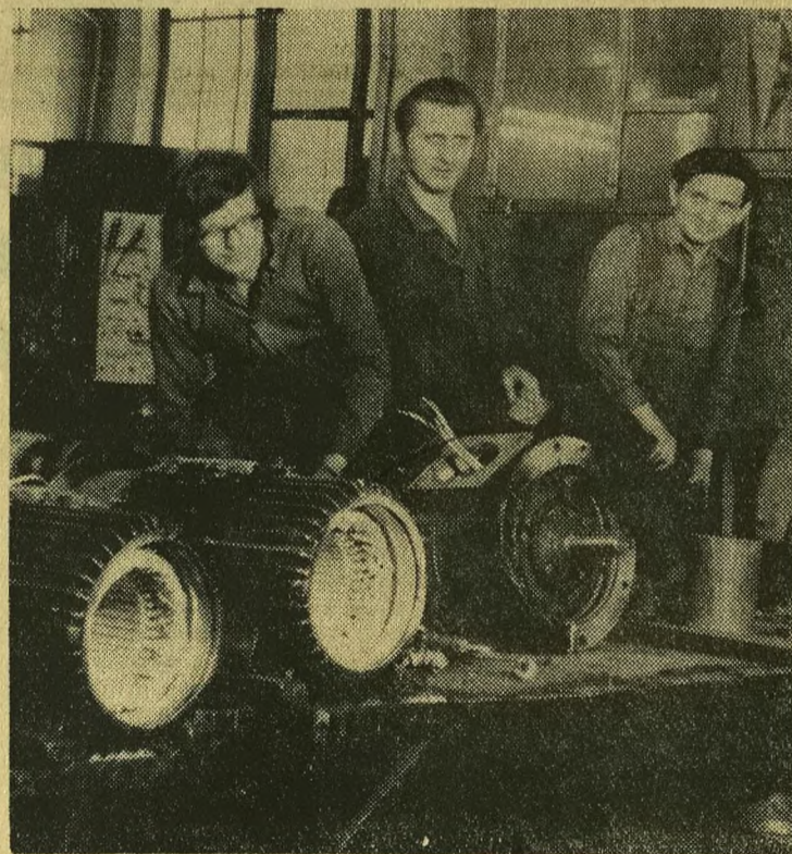
Brygada Jana Kawczyńskiego w trakcie montażu
