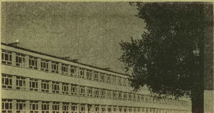
Nowoczesny budynek Technikum Kolejowego Ministerstwa Komunikacji im. Tomusza Zapaly.
