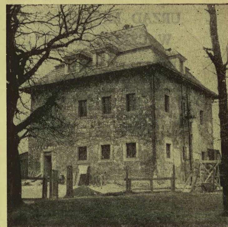
Dworek w Dobrezowicach w odbudowie
