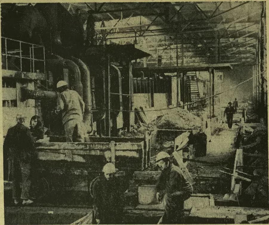
Budowa nowego pieca tunelowego w Rogoźnickich Zakładach Ogniotrwałych.
